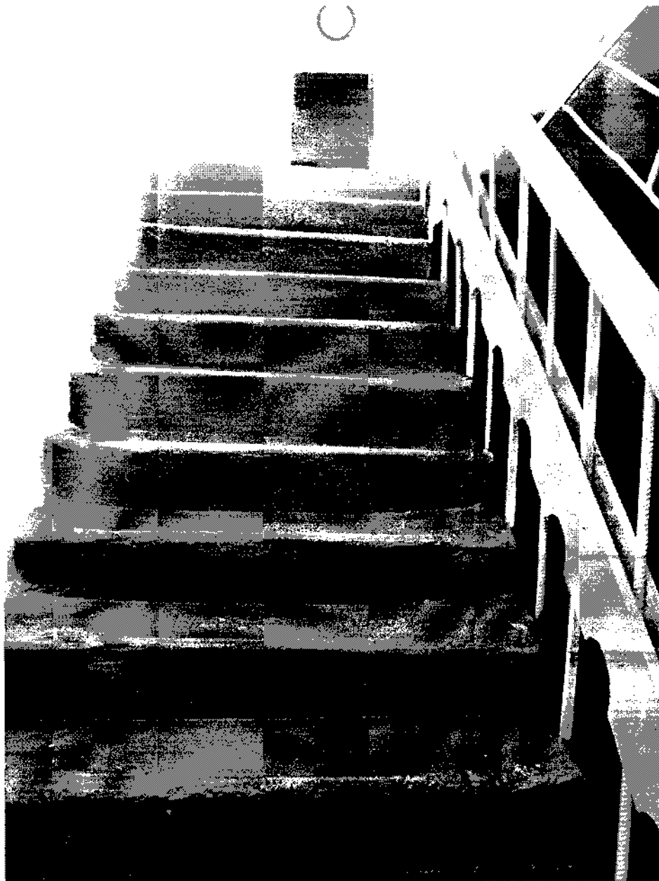
Лестница в подвал(27)
